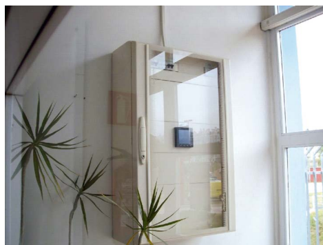
Ilustración 2: Cuadro de Medida Integración Básica
